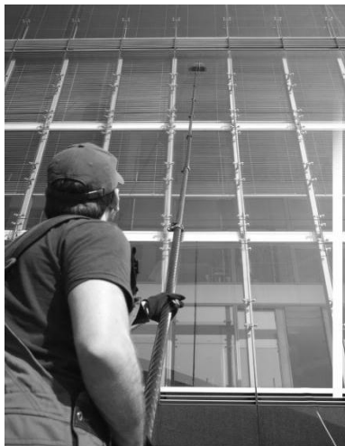
Рисунок 2. Мойка при помощи телескопической штанги
