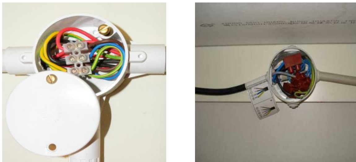
Рисунок 1 - Вид на соединение проводов в ответвительной коробке Виды ответвительных коробок
