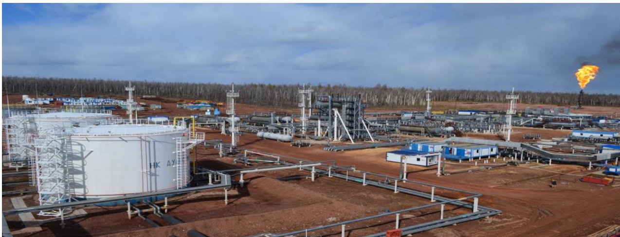
Рисунок 1- Общий вид района работ (РВС, УПН, энергоцентр и факельная установка).
