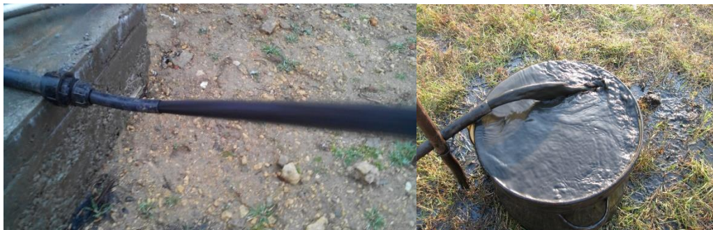
Рис. 3. Откачиваемая вода с кольматантом после виброволнового воздействия (без химреагентов) из скважин питьевого назначения, ст. Старотитаровская, Краснодарский край
