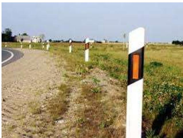
Рисунок 2. Устройство светоотражающей дорожки желтого цвета на поворотном месте
